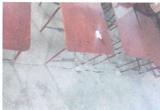
Foto 2: MEJORAMIENTO DE PISO DE AULAS .
