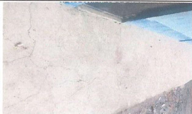
Foto 1: MEJORAMIENTO DE PISO DE AULAS .
