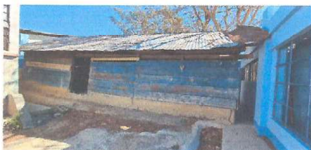
Foto 3: MEJORAMIENTO DE COCINA TIPO PORTICO ESTRUCTURA Y TECHADO DE LAMINA TROQUELADA CALIBRE 26.
